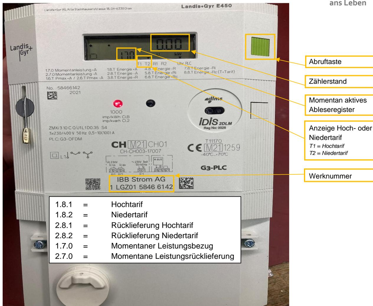
Die Zählerstände können auf der Anzeige direkt entnommen werden. Diese rotiert alle 10-15 Sekunden.
